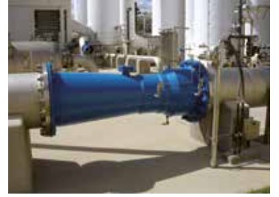
الشكلُ (33): مقياسُ فنتوري في إحدى محطاتِ المياهِ.
